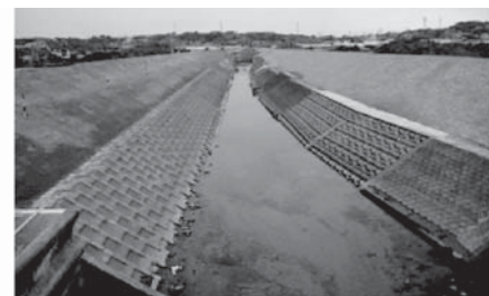
堤防の高上工 中西川（御前崎市白羽地先）
