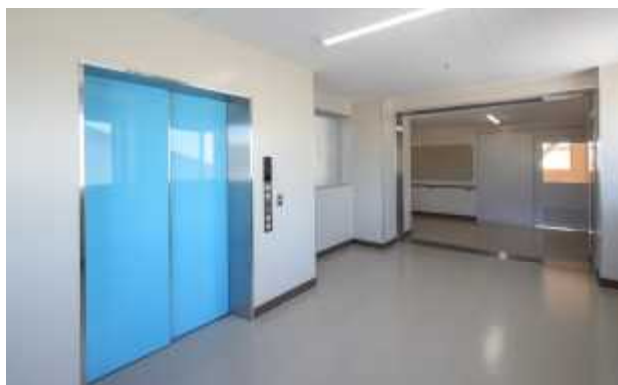
エレベーターの設置
