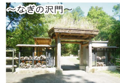
入口をはじめ各広場やポイントには、それぞれを解説した案内版が設置されています。
