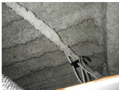
天井吹き付け材
