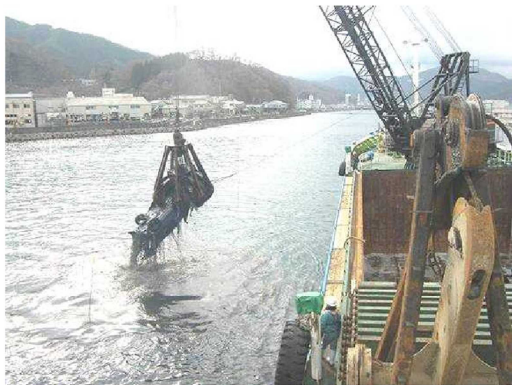
海上啓開作業：岩手県釜石市 出典：東北地方整備局
