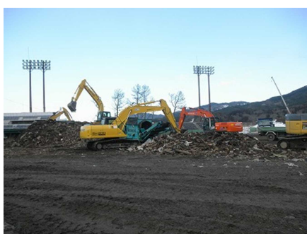
図4 重機による粗選別
