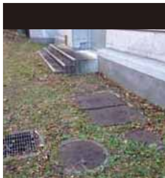
建物の給排水設備を調べる
