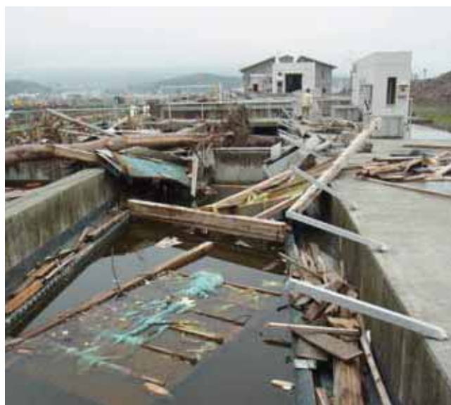
被災した汚水処理施設
